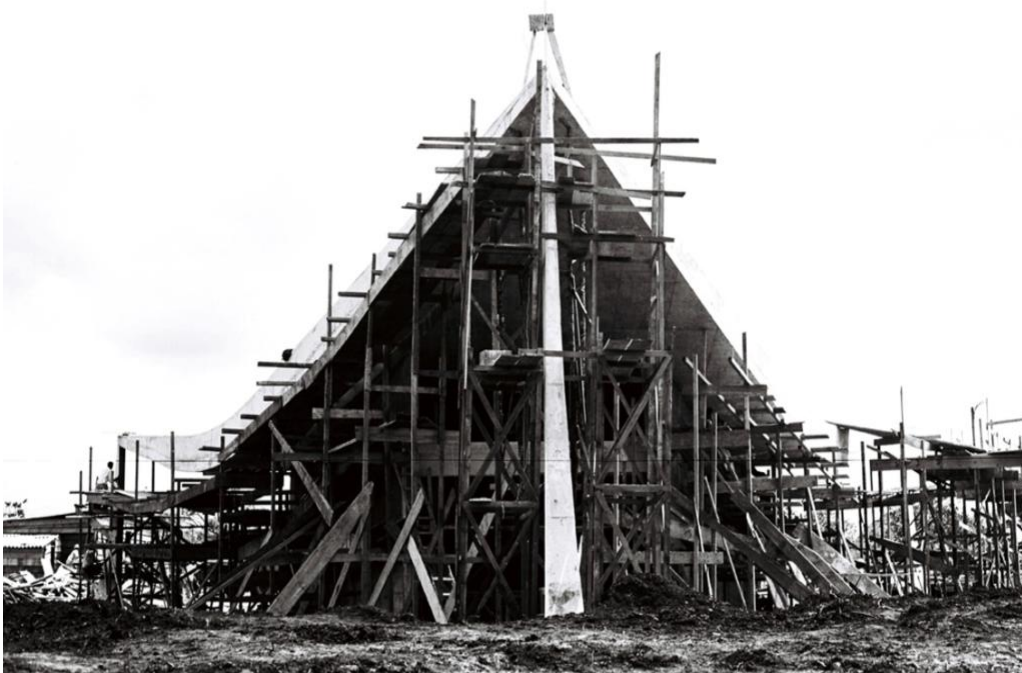
Figura 19 - Igrejinha Nossa Senhora de Fátima em construção, 1957
