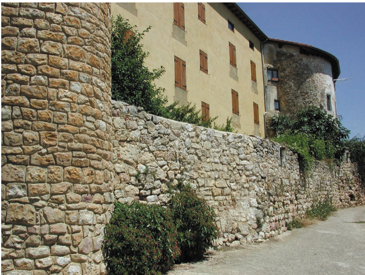
Casas integradas en los torreones y lienzos de muralla exentos en Peñacerrada (Álava)
