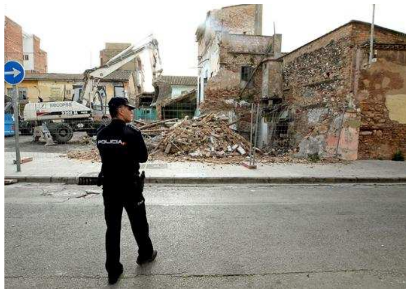
Agente vigilando orden de derrumbe en el barrio del Cabañal.
