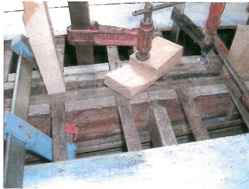
Restauration du puits de dérive de Quod Amo
