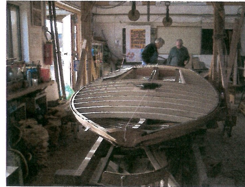
Remplacement des barrots de pont de Quod Amo
