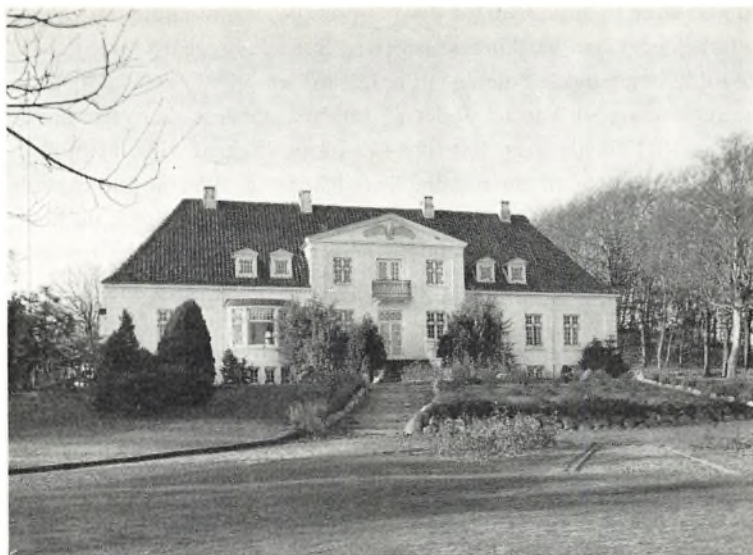
Hovedbygningen set fra øst (fot. Niels Elswing).
