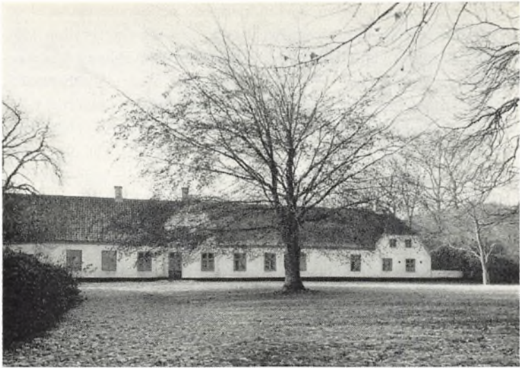
Hovedbygningen set fra øst (fot. Niels Elswing).
