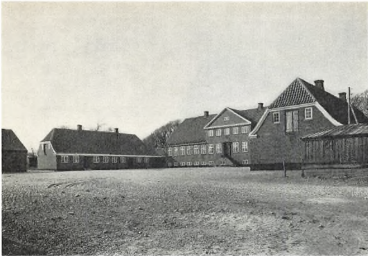
Hovedbygningen set fra sydøst (fot. Aa. Roussell).
