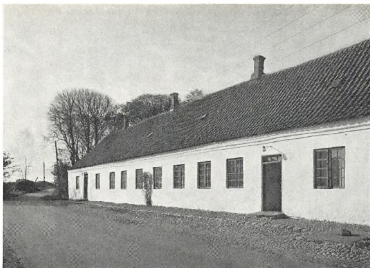
Hovedbygningen set fra øst (fot. Niels Elswing).
