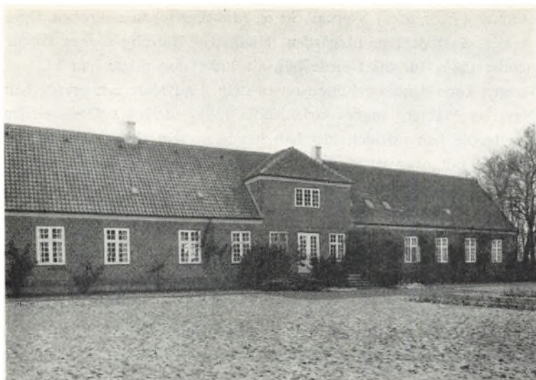
Hovedbygningen set fra øst (fot. Niels Elswing).
