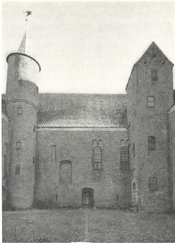
Østfløjens gårdside. Den tilmurede dør i 2. stokværk har fra Bispens Sal ført ud til en svalegang, der blev nedlagt, da de 10 trappe- tårne blev opført ca. 1580 (fot. Niels Elswing).
