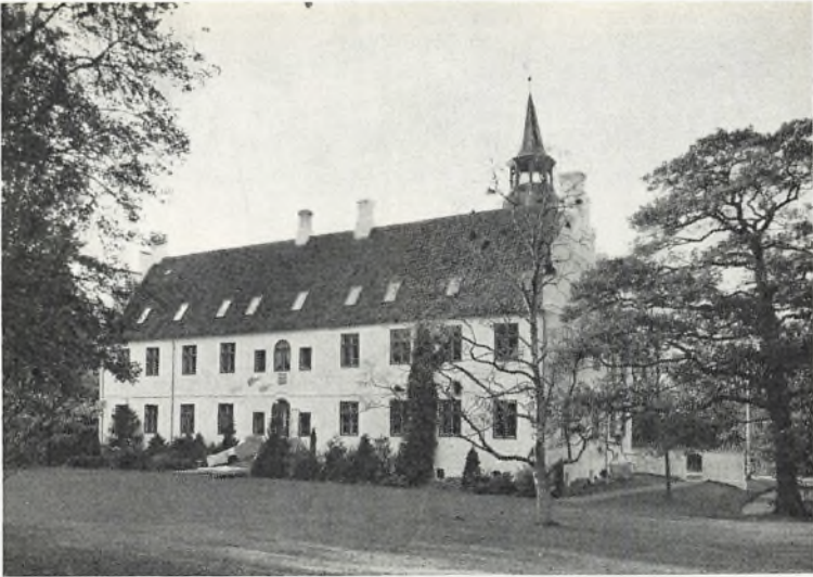
Hovedbygningen set fra øst (fot. Niels Elswing).
