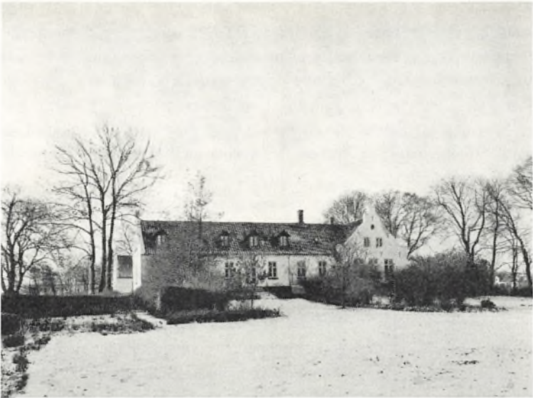
Hovedbygningen set fra øst (fot. Niels Elswing).
