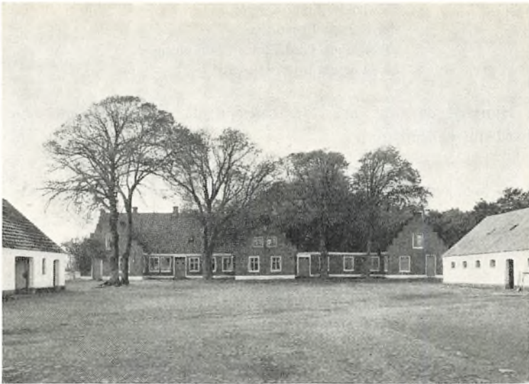
Hovedbygningen set fra øst (fot. Niels Elswing).
