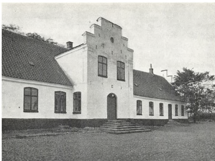
Hovedbygningen set fra øst (fot. Niels Elswing).
