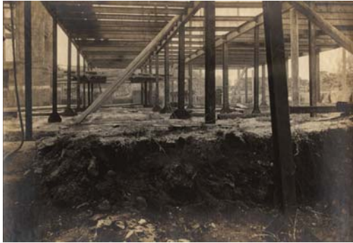
Konstrukcija biblioteke, sustav armiranobetonskih stupova i čeličnih greda
