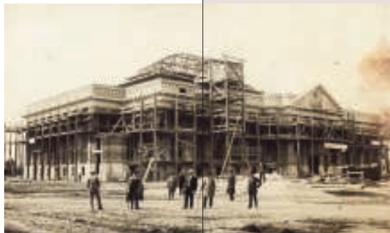
Biblioteka u gradnji (1912.)
