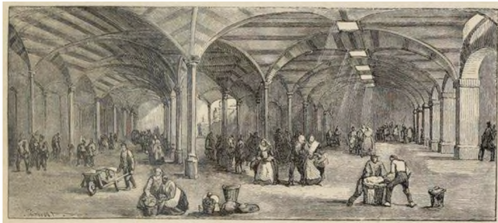
VUE DES CAVES.
