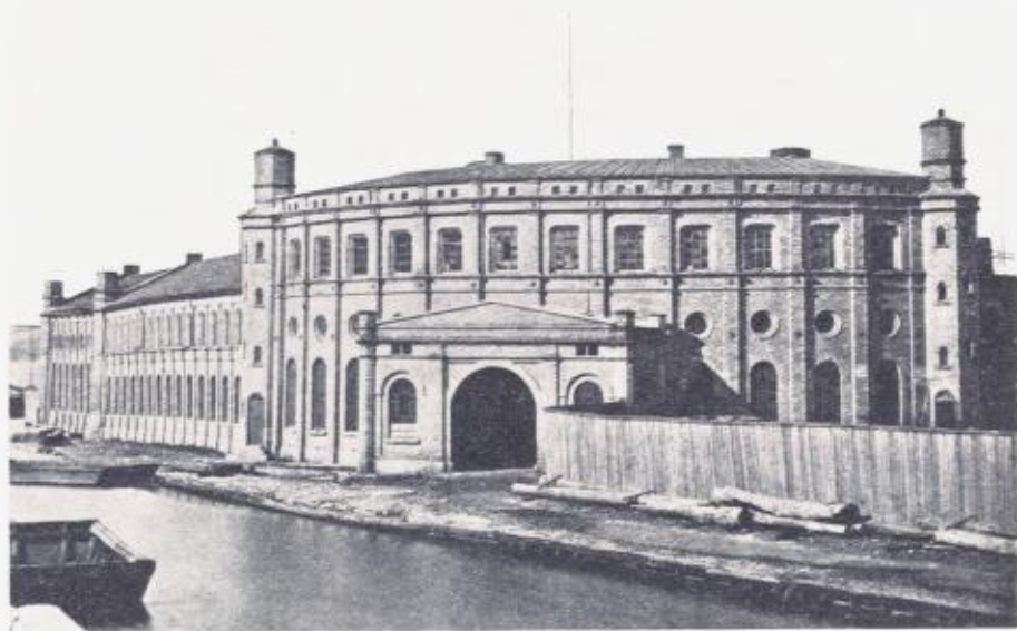
Nylands mekaniske verksted. Efter fotografi.
