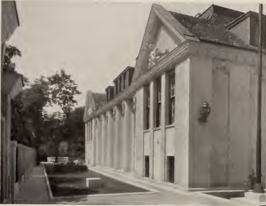
Josef Hoffmann — Gartenwohnhaus in Wien-Hietzing (Straßenseite).
