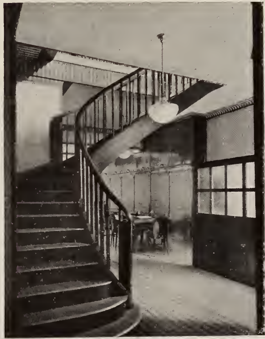
Josef Hoffmann — Innenstiege der Poldihütte.
