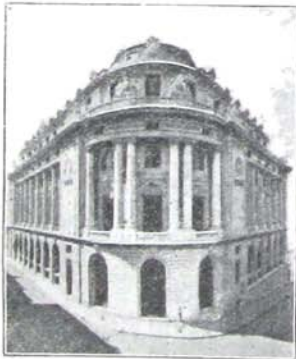
Nuevo edificio de la Bolsa
