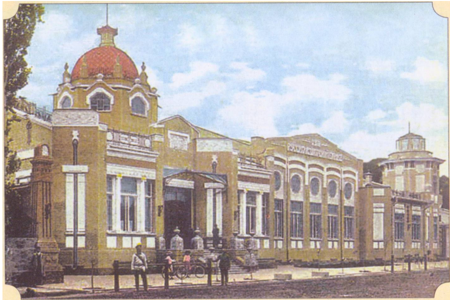
Здание Русско-Азиатского банка в Коканде. Построено в 1910 г. по проекту И.А. Маркевича. Фото 1910 г.
