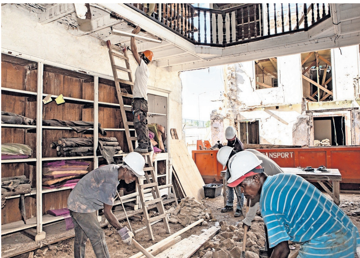
Het gebouw van de voormalige modewinkel La Moda de Paris wordt gerestaureerd. FOTO'S SINAYA WOLFERT
