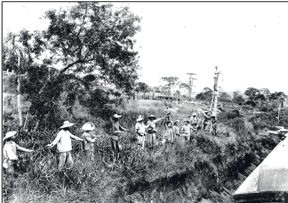
Companhia de Engenheiros do 2º Btl no restabelecimento da linha telegráfica da Estrada de Ferro entre Canoinhas, SC e Porto União da Vitória, PR, interrompido pela ação dos rebeldes (Fonte: Rodrigues, 2008, apud Setor de Iconografia do AHEx)
