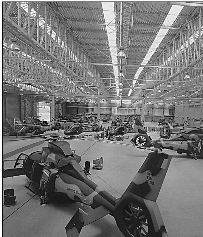
Hangar da Base de Aviação de Taubaté Fonte: BIBLIEx, 1998, p. 249)
