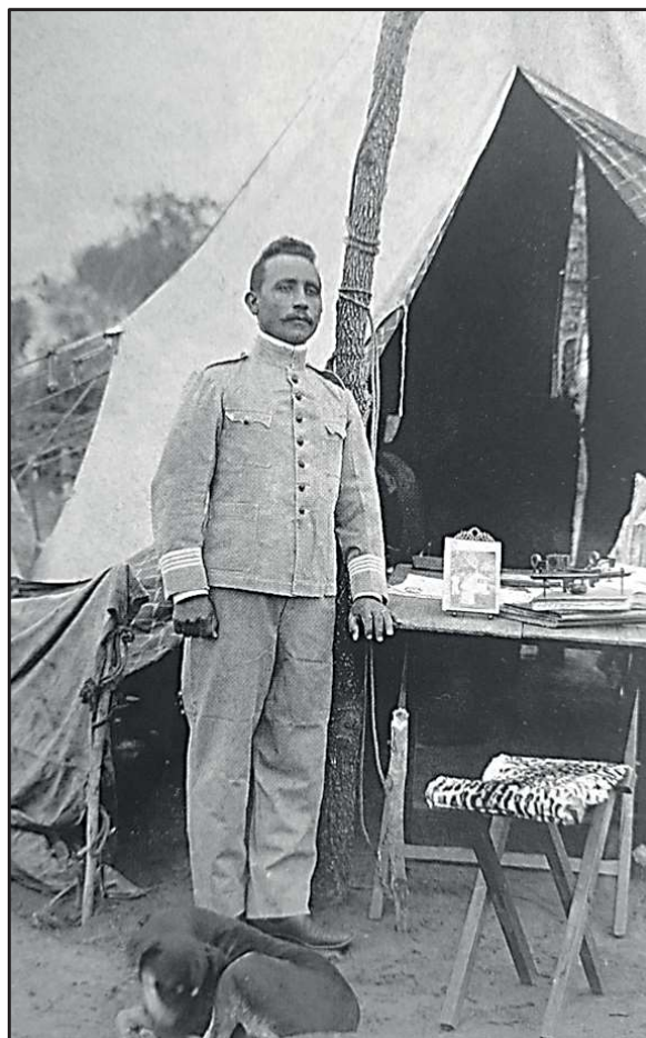
Rondon em acampamento durante a construção de linhas em Mato Grosso (1903) (Fonte: BIBLIEx, 1998, vol. 3, p. 70)
