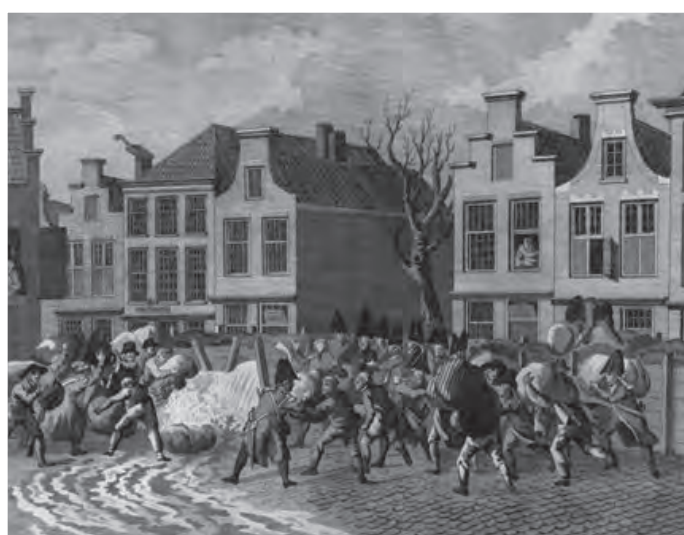
Op deze gravure van C. Bogerts zien we de Kortendijk in 1809, terwijl een doorbrekende kistdam met man en macht wordt verstevigd. Koning Lodewijk Napoleon (midden) komt poolshoogte nemen en lijkt te helpen het gat te dichten. De putjes, waaruit de kistdam werd opgebouwd, zijn nog steeds in de Kortendijk aanwezig.
