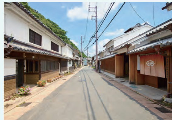
たつの市龍野伝統的建造物群保存地区 提供 たつの市
