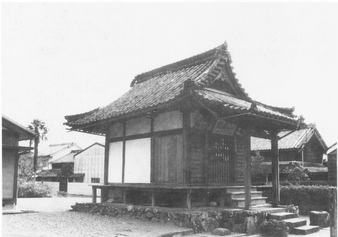
三尊寺観音堂（北西から）
