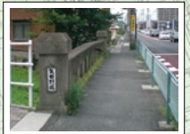
28 矢田野橋 小運河に架かる橋。
