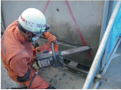
ダブルブレードカッターの実地検証
