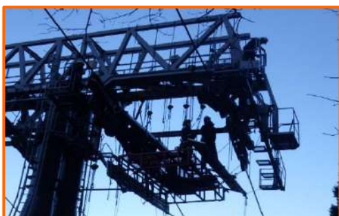
支柱受索装置整備
