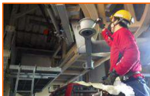
搬器懸垂装置整備
