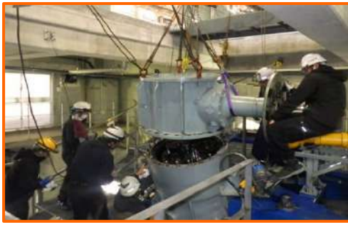
主減速機分解整備
