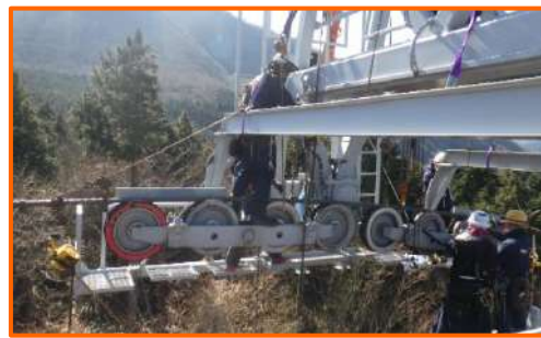
支柱受索装置整備
