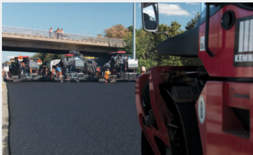
Einbau von Drainsphalt PA 8 auf der BAB A2 bei Hannover in 2016
