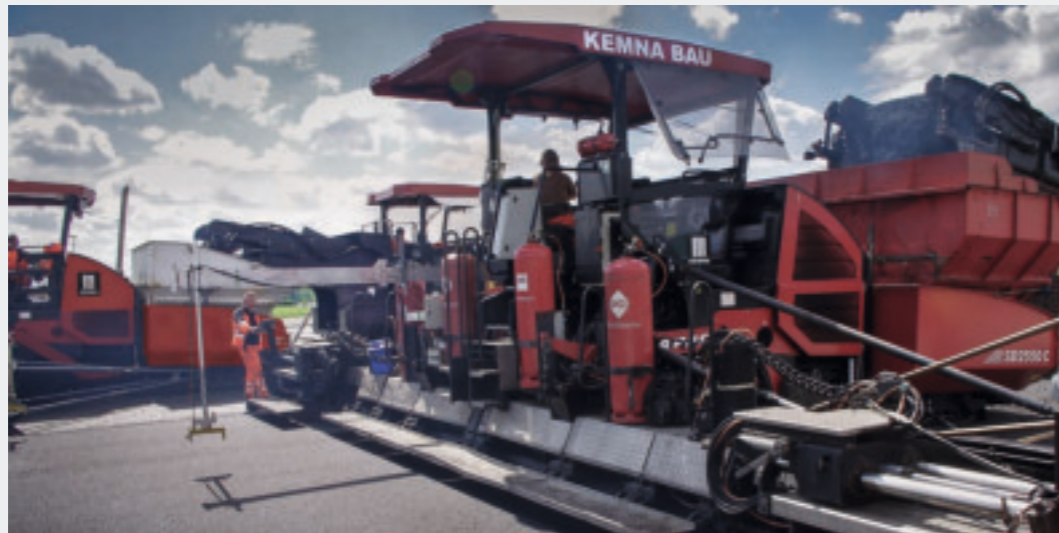
Asphalteinbau in großen Breiten: Start- und Landebahn des Airbus-Flughafens Finkenwerder in Hamburg
