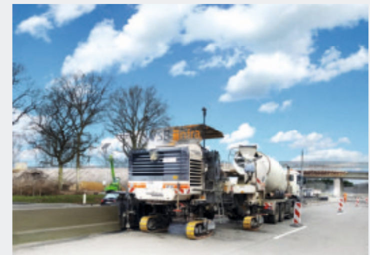
Herstellung von Ortbetonschutzwänden auf der BAB A7 durch VSB infra
