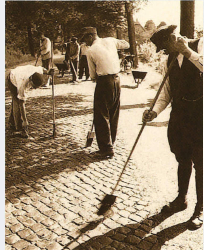
Vorbereitung für einen Pflasterüberzug (B 4 zwischen Quickborn und Wiemersdorf)
