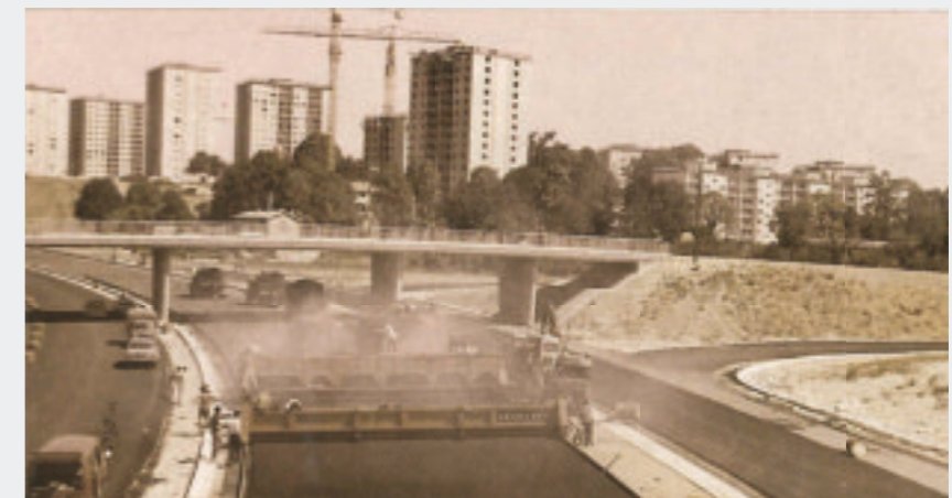
Gussasphalteinbau nördlich von Lyon, Frankreich
