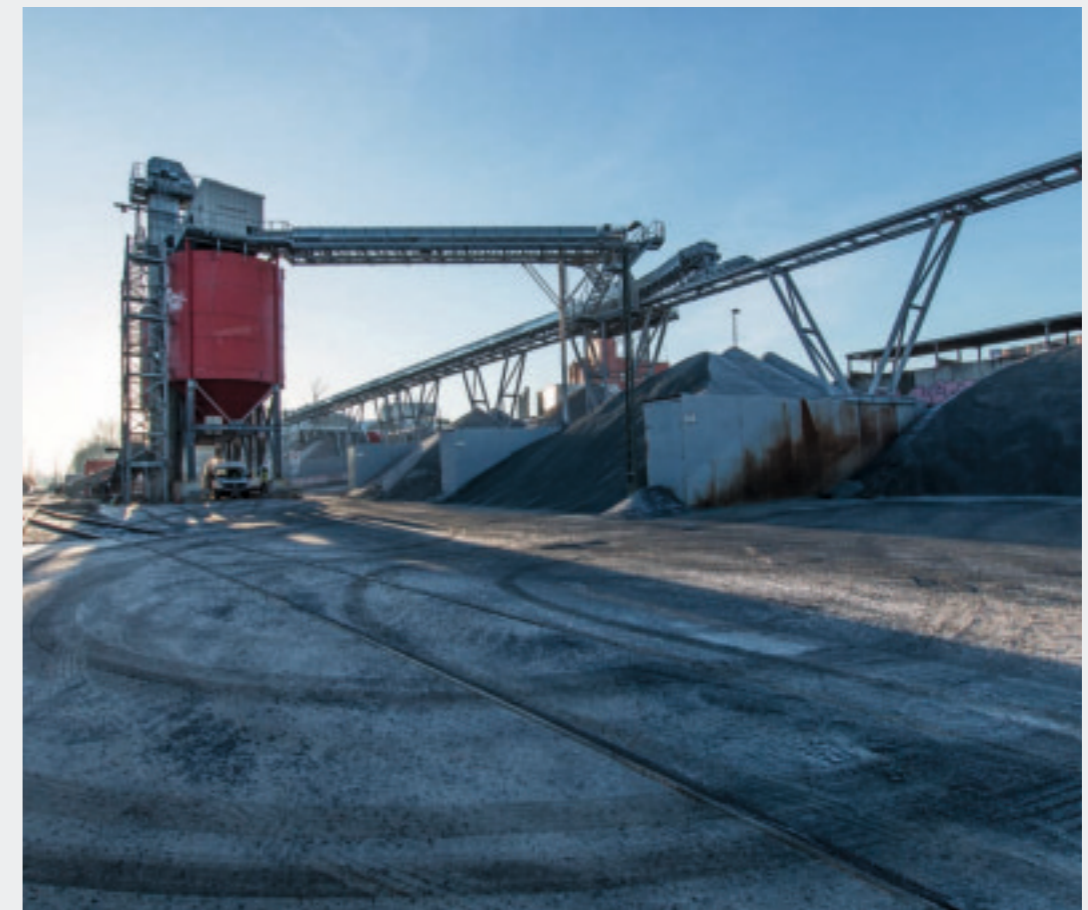
Siloanlage mit Förderbandanlage zur Boxenbeschickung
