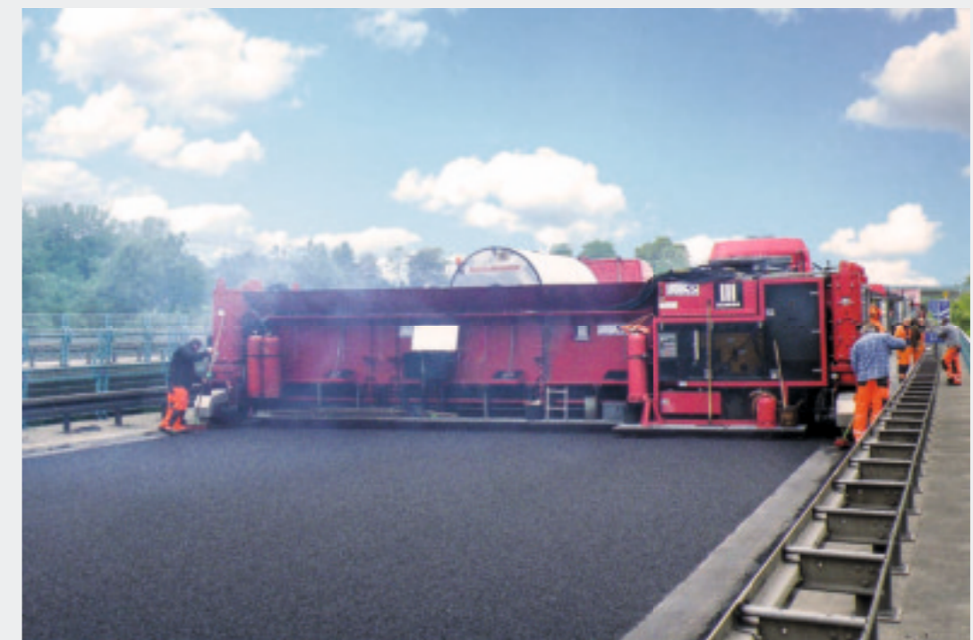
Moderne Gussasphalt-Einbaubohle auf der BAB A20 in voller Breite
