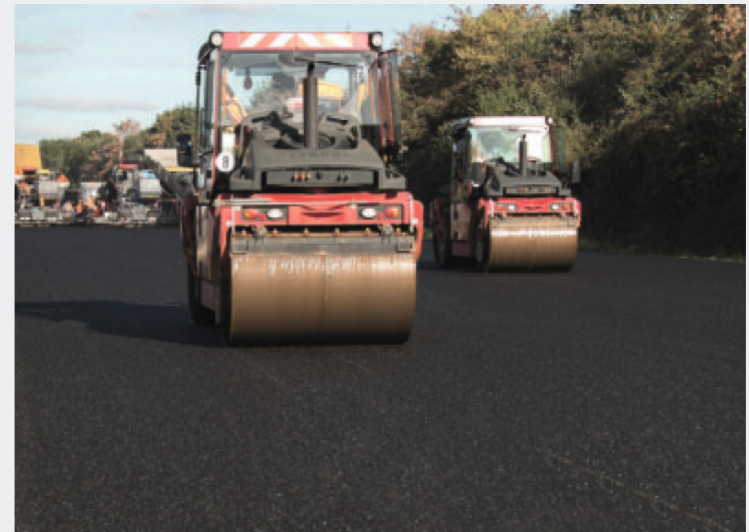
Einsatz von Walzen beim Asphalteinbau
