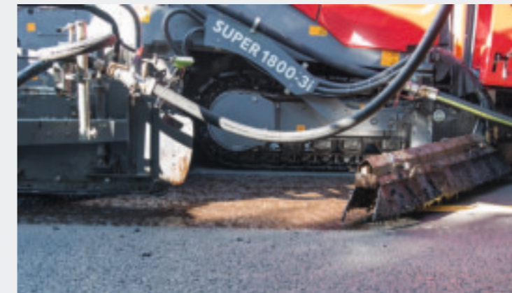
Vorsprüheinrichtung am DSH-V-Fertiger beim Einbau eines PA 8
