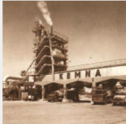
◀ Asphaltspalt-Werk Anderten in den 1970er Jahren
