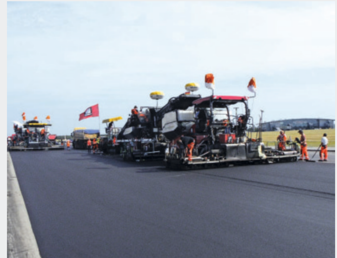
Einbau einer Kompakten Asphaltbefestigung auf dem Flughafen Rostock-Laage
