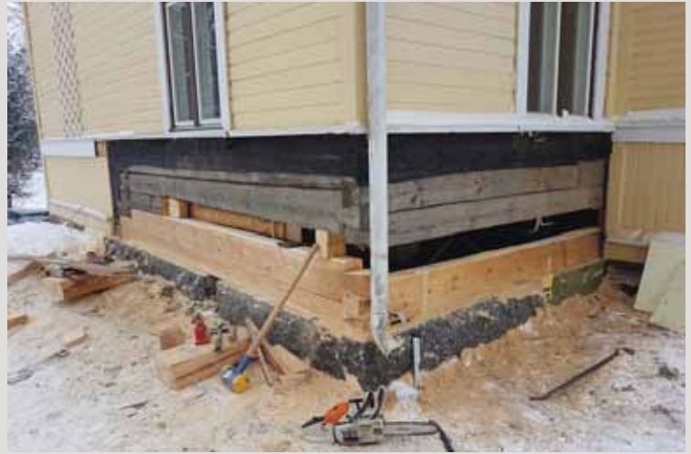
Hirsien vaihto eli kengitys on hirsitalon huoltotoimenpide. Nurkan korjaus ja valokuva Perinnerakentaja Leo Lönnroth Oy
