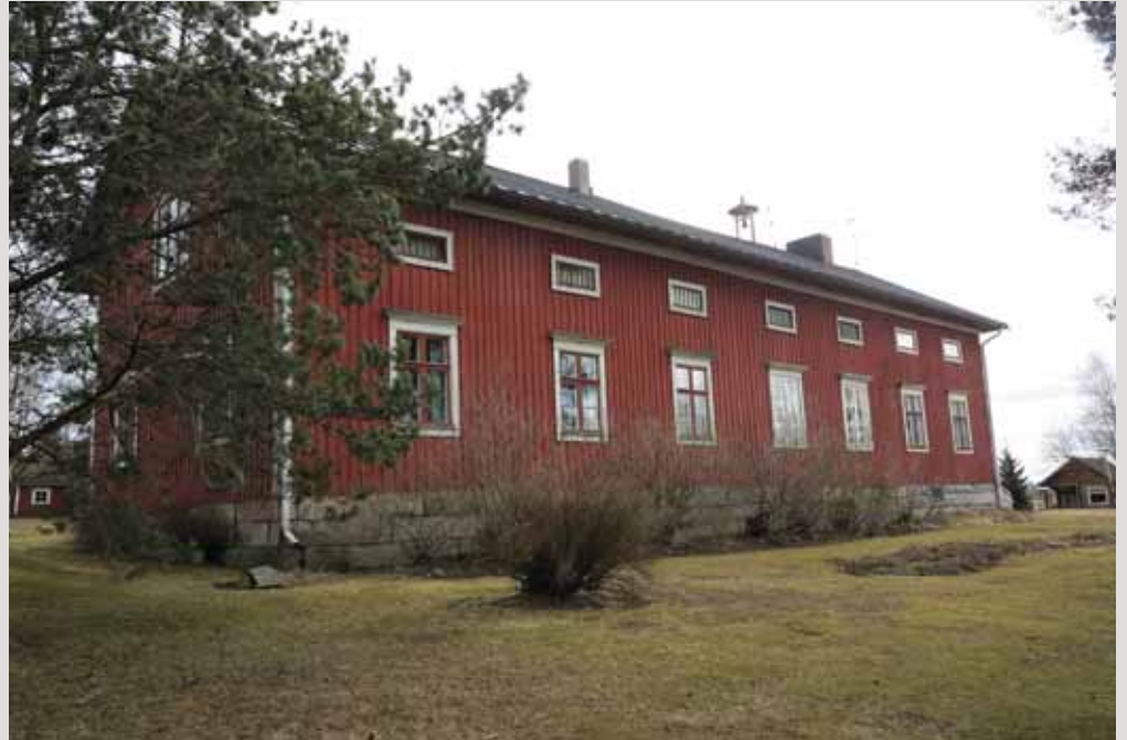
Vanhoja valokuvia tarkastellessa huomaa, että pitkänsivun aukotus on muuttunut, entisten pohjoispään kahden ikkunan sijaan yksi ikkuna on niiden tilalla.
