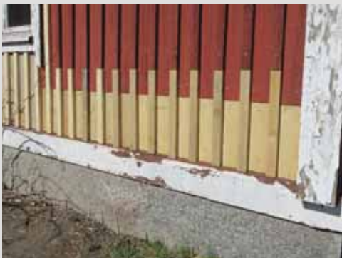
Rakennuksen helma paikataan vain osittain, vanhaa laudoitusta säilytetään mahdollisimman paljon.
