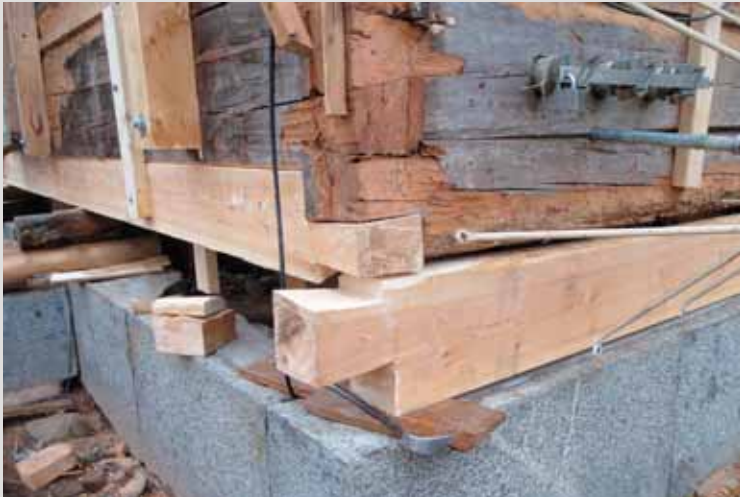
Vuonna 2017 Jalasjärven kirkon sakastiosan korjauksessa soviteltiin mm. uusia hirsii vahingoittuneiden tilalle. E. Paloniemi Oy
