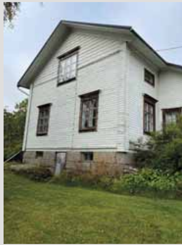
2-3-jakoiset ns. kitti-ikkunat. Alakerran ja kuitien ikkunat ovat 6-ruutuiset, osa ruuduista
