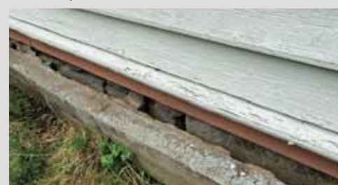
Betonipinta kivijalan pinnasta joutaa irtomaan, alla on taloa kannattelava, ryhdikäs lohkokiviperusta.
