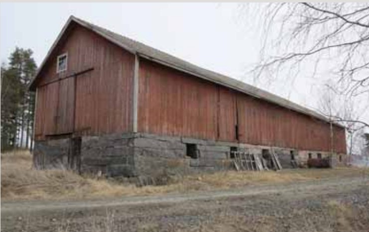
Juho Kiviniemessä Ala-Vallissa on vuonna 1876 rakennettu kivenavetta.
