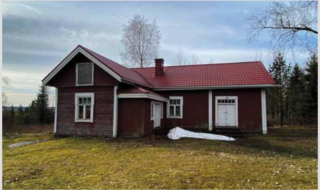
Kulunut sementtitiilikatto vaihtui profiilipeltiin kesällä 2019.
