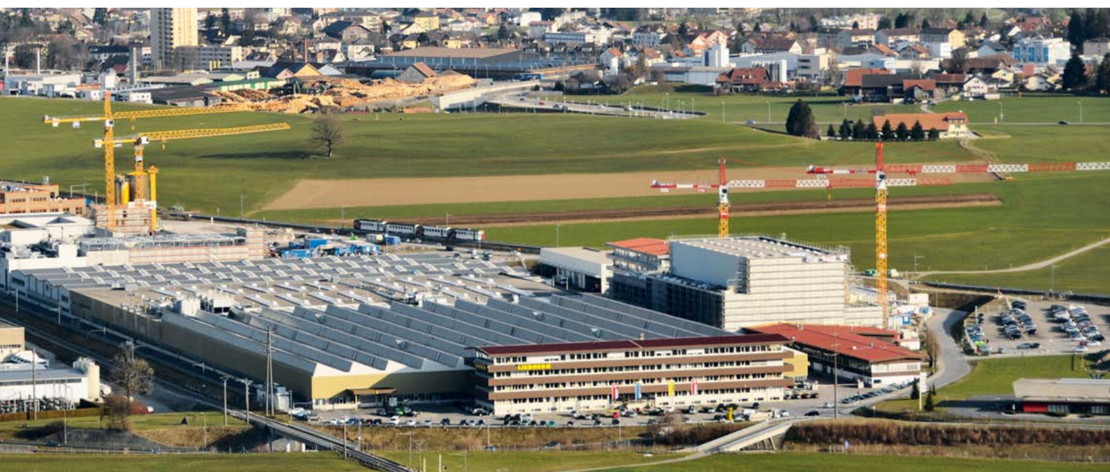
Erweiterung des Werkes für Diesel- und Gasmotoren in Bulle, Schweiz
