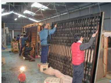
重要文化財のお寺 「部戸」（しとみど）修復作業
