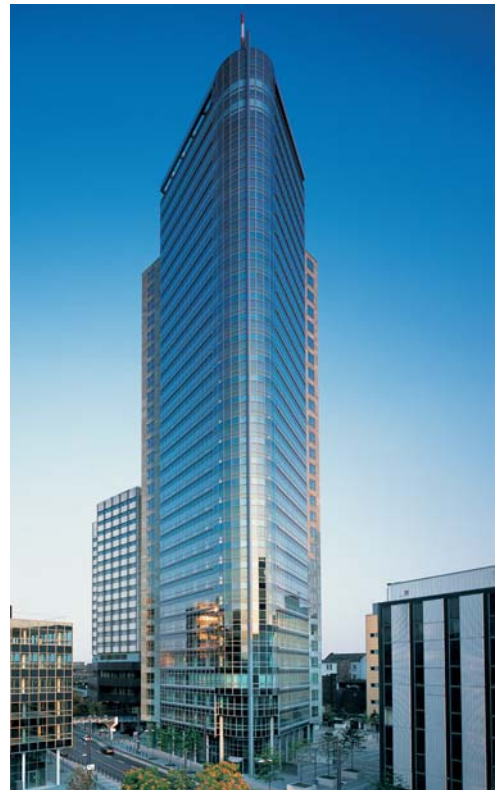
CityTower, Offenbach, Tyskland
