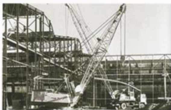
Construction du site de Loirecord
