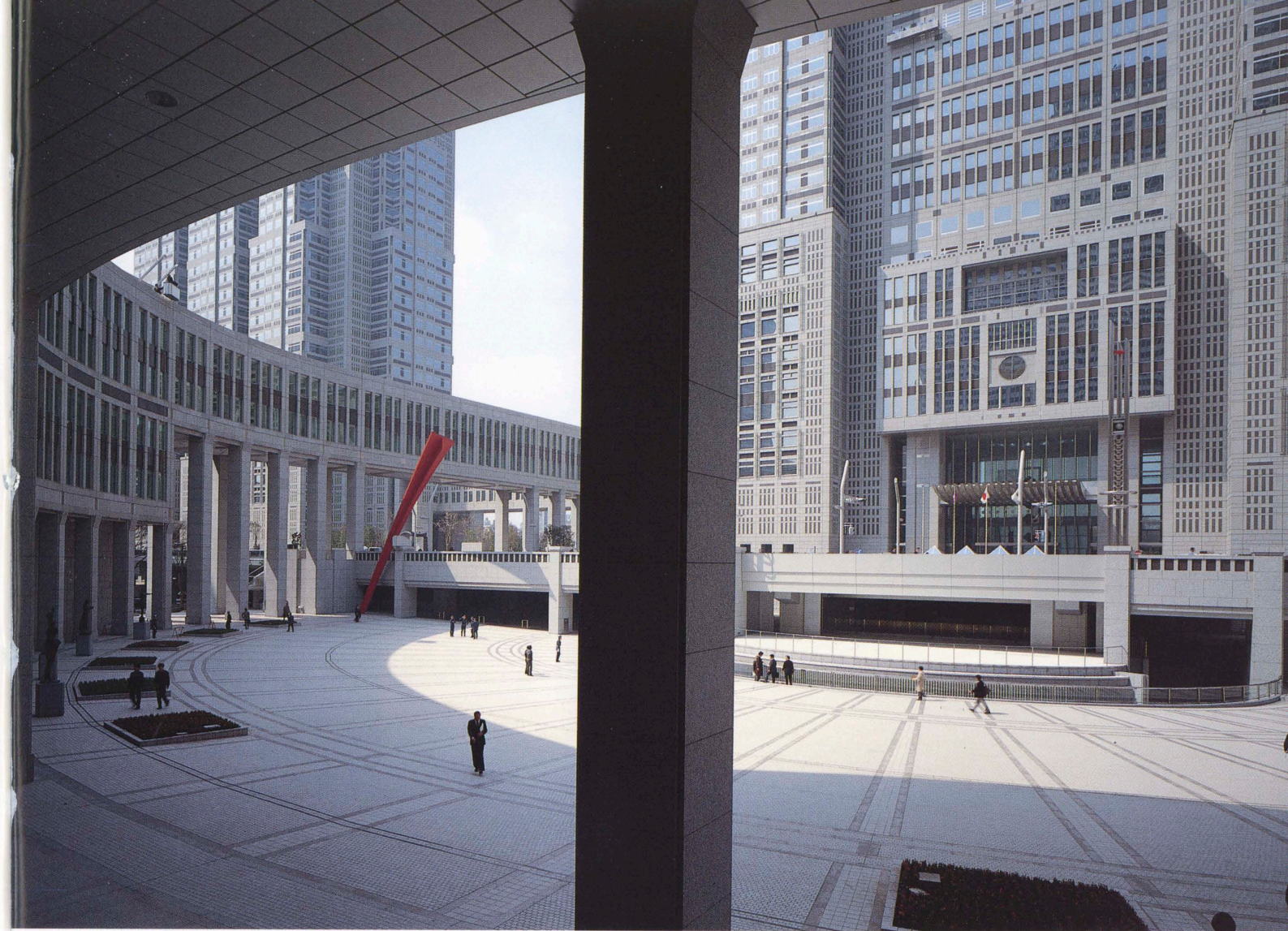
議会議事堂前の都民広場を通して第1庁舎と第2庁舎をみる Civic plaza in front of the city council.
