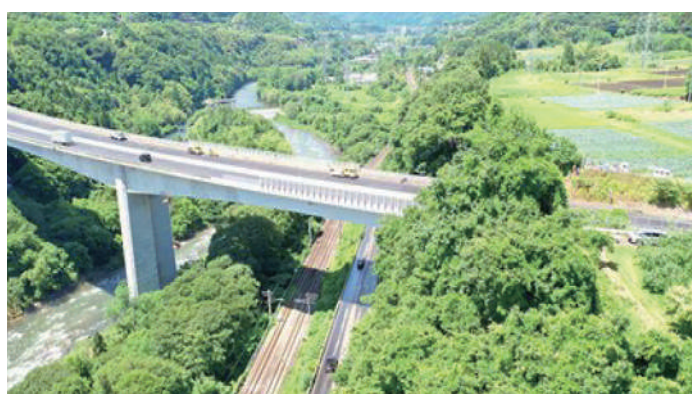
関越自動車道 沼尾川橋橋梁補修工事
