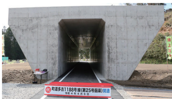
首都圏中央連絡自動車道 多古地区函渠工事
