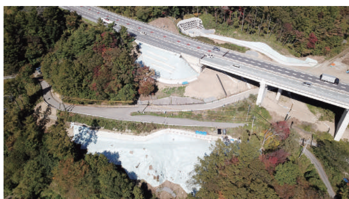
上信越自動車道 香坂地区のり面補強工事
