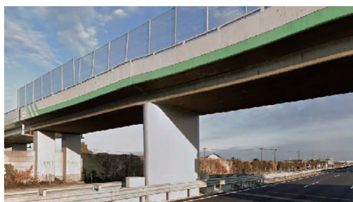
東北自動車道 水深橋跨高速道路橋(ロックンク橋脚) 耐震補強工事
