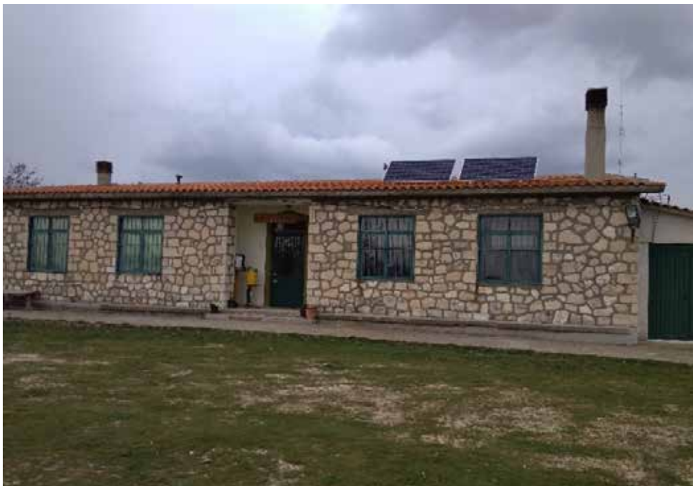
Εικόνα 4. Φωτοβολταϊκά πάνελ - Η σημερινή κατάσταση (Λεμπέση 2021).
