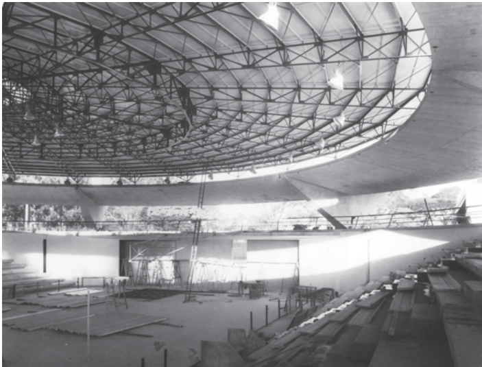
Construção do ginásio durou pouco mais de 1 ano e meio
