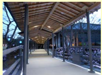
新公会堂とシルクロード交流館結ぶ渡り廊下（H24. 2完成）
