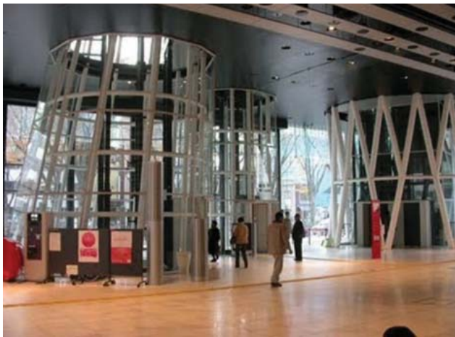
Estructura en acero. Mediateca de Sendai, de Toyo Ito.
