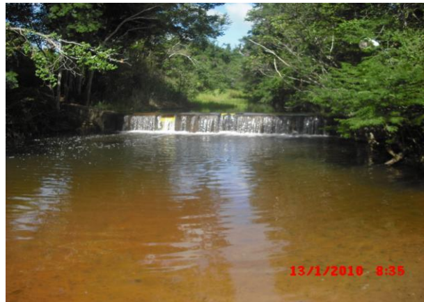
Figura 6: barramento no município de Condeúba.
