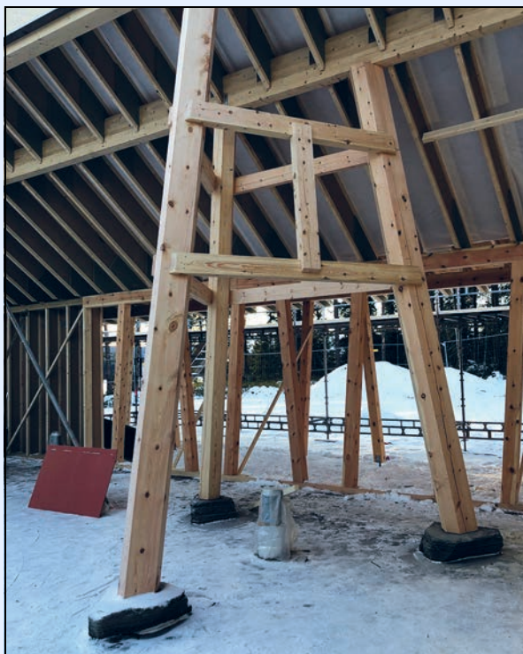
Figur 2.2 Nybygget for Saemien Sijte på Snåsa er under oppføring og skal etter planen stå klart for innflytting ultimo 2021.
