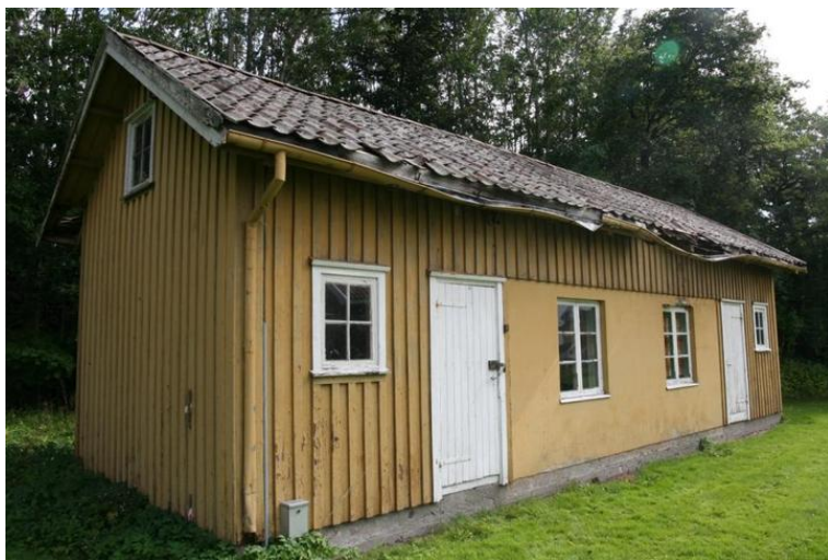
Felles uthus for beleggshus 17A og 17B Opphavsrett: Statsbygg.
