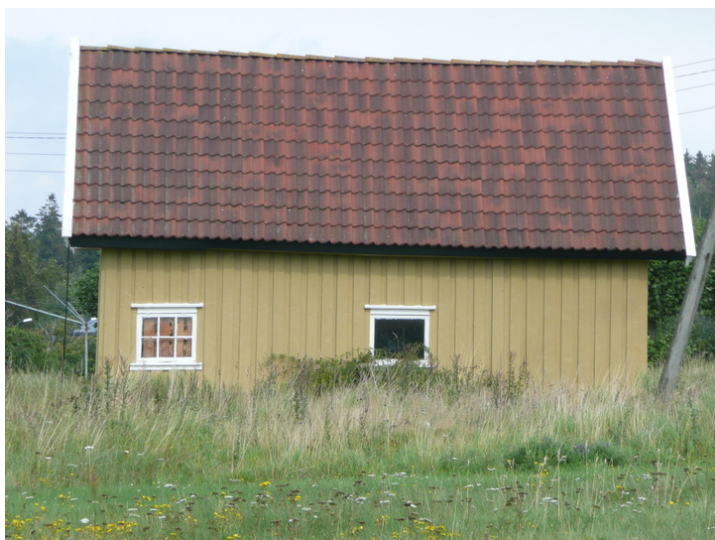
Uthuset har panel og takstein fra nyere tid. Opphavsrett: Statsbygg.
