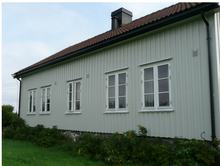
Fasaden mot sjøen. Opphavsrett: Statsbygg.
