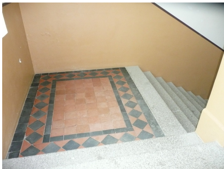
Trappeavsats. Opphavsrett: Statsbygg.
