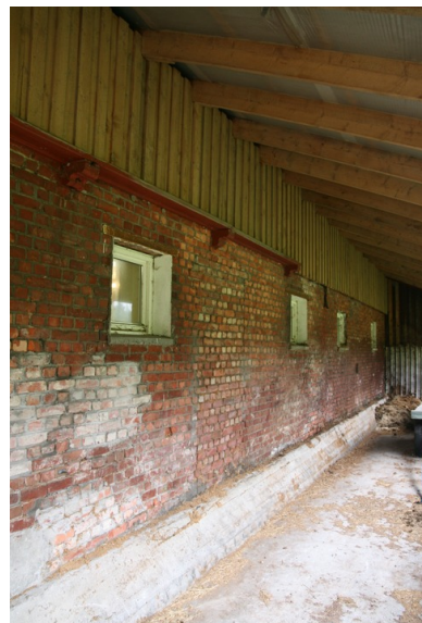
Bak stallen er det trukket ut et overhengende tak. Opphavsrett: Statsbygg.
