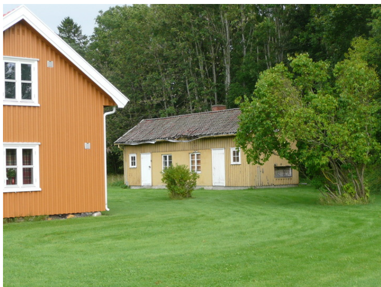
Uthuset plassering i forhold til belegghus 17B. Opphavsrett: Statsbygg.
