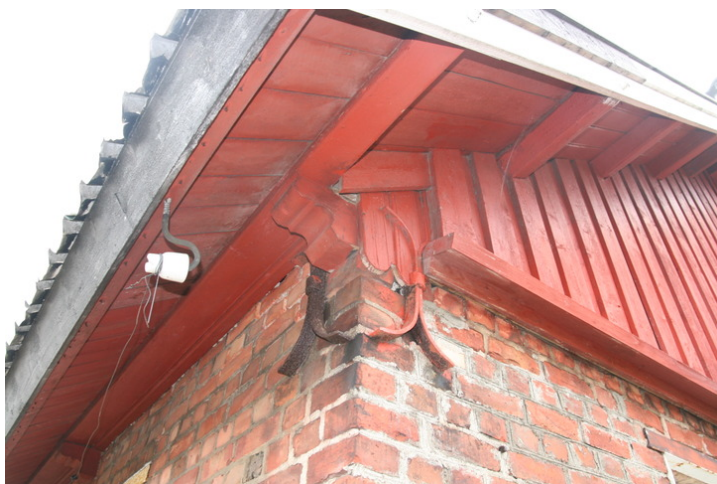
Detalj. Opphavsrett: Statsbygg.
