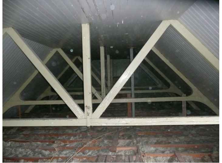
Opprinnelig tak og takstoler fra den store sovesalen er synlig på loftet. Nytt tak er lagt under det gamle. Opphavsrett: Statsbygg.
