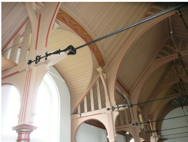
Fin detaljering i kirkerommet. Opphavsrett: Statsbygg.
