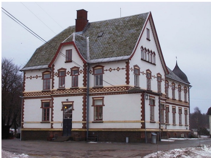
Administrasjonsbygg fra nord 2000 Opphavsrett: Kriminalomsorgen.
