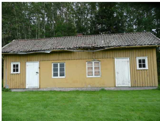
Uthuset er Symetrisk innredet. Opphavsrett: Statsbygg.
