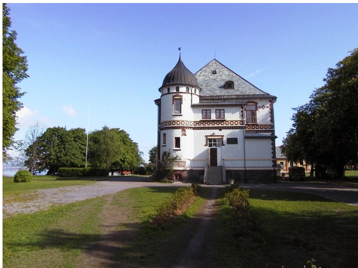
Adm.bygg fra syd 2001 Opphavsrett: Kriminalomsorgen.
