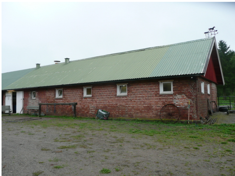
Den eldste delen er i dag stall. Opphavsrett: Statsbygg.
