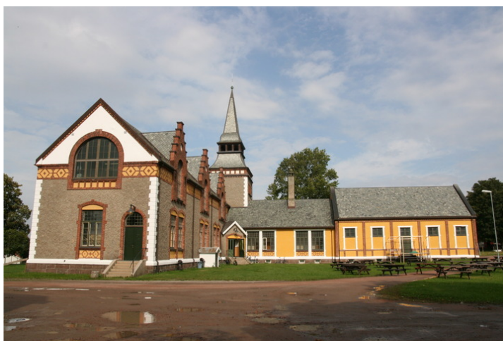
Kirke- og skolebygning. Opphavsrett: Statsbygg.
