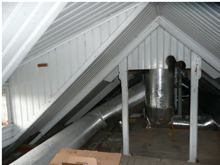
Loftet hvor det opprinnelige taket i sovesalen er bevart. Opphavsrett: Statsbygg.
