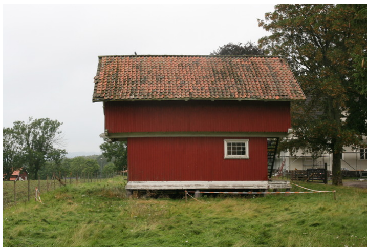
Stabburet sett mot vest. Opphavsrett: Statsbygg.
