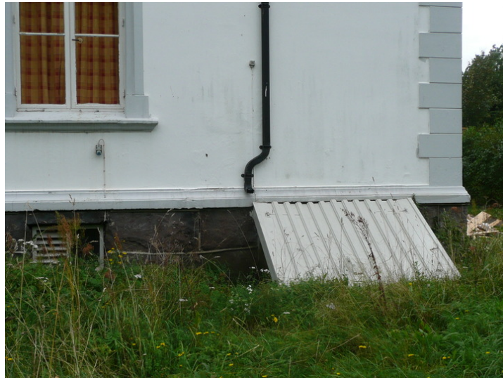
Kjellerlemmen på hjørnet av nordveggen. Opphavsrett: Statsbygg.
