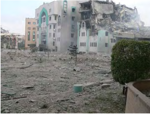
מבנה הפקולטה למדעים באוניברסיטה האסלאמית בעזה לאחר תקיפת חיל האוויר (אתר הפורומים של גדודי עז אלדין אלקסאם, 31 בדצמבר 2009)
