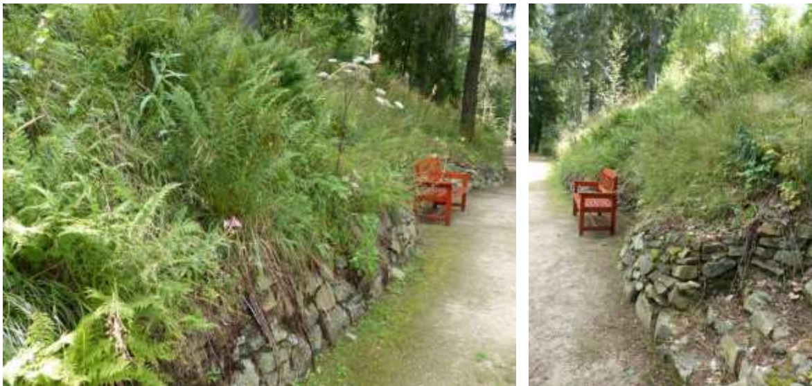
Obr. 13 Současný stav, pohled od paty svahu.
