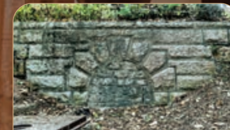
已封閉的隧道口 Sealed Tunnel Portal
