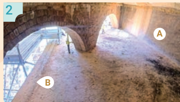
A 原牆身(1904年) Original Perimeter Wall built in 1904
